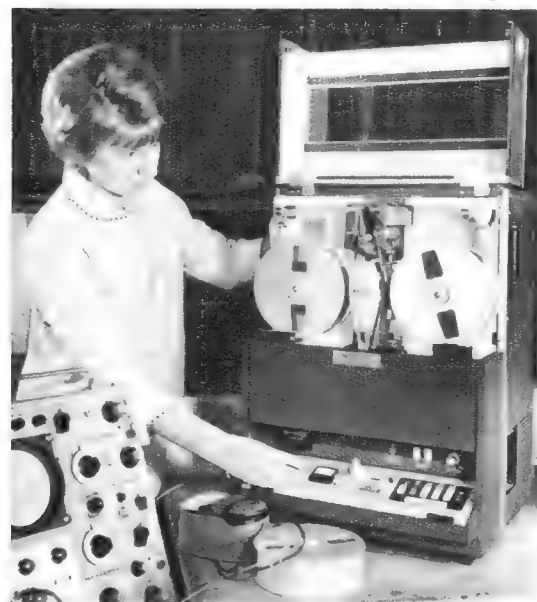
Links: Für Farbprogrammaufzeichnung erweiterter Videorecorder PU-120 UE von Sony im Laboratorium der CFT, Paris. Das Gerät kostet etwa 40 000 DM
